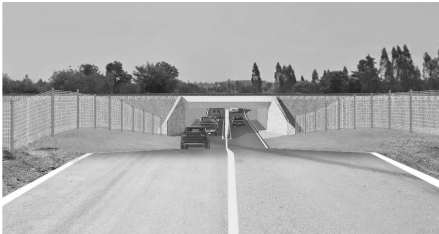
รูปที่ 2.4-2 การก่อสร้างถนนลอดทางรถไฟ
