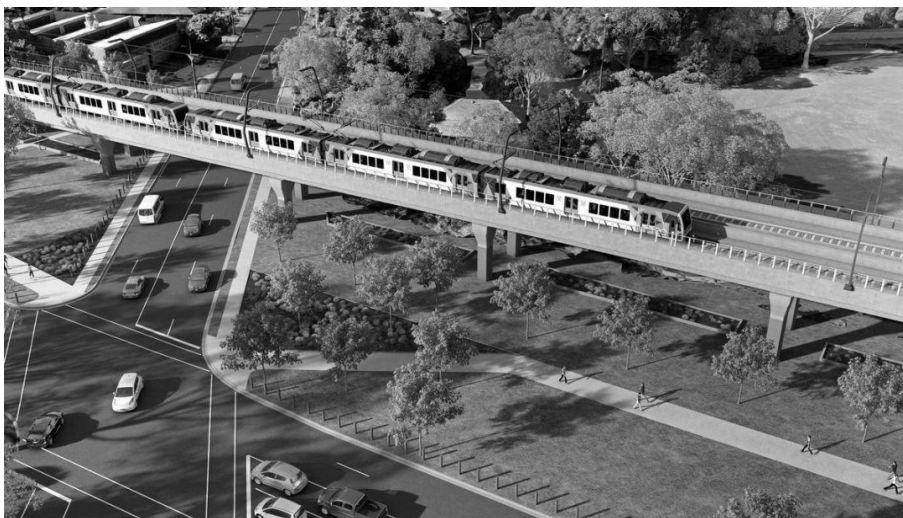
รูปที่ 2.4-3 การก่อสร้างทางรถไฟยกระดับ
