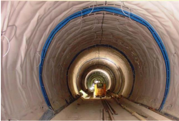
รูปที่ 3.4-2 รูปแบบการป้องกันและระบายน้ำในอุโมงค์
