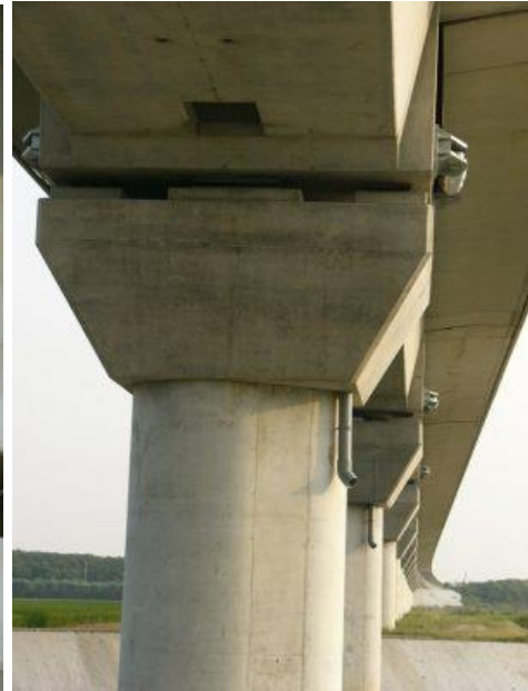
รูปที่ 3.3-8 ตัวอย่างทางวิ่งยกระดับรถไฟความเร็วสูงในประเทศไต้หวัน ติดตั้งอุปกรณ์ Lock-Up Devices
