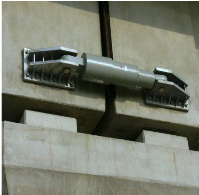
รูปที่ 3.3-8 ตัวอย่างทางวิ่งยกระดับรถไฟความเร็วสูงในประเทศไต้หวัน ติดตั้งอุปกรณ์ Lock-Up Devices
